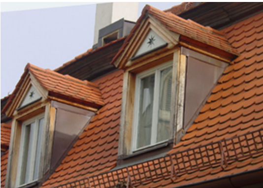
historische, sanierte Satteldachgaube
