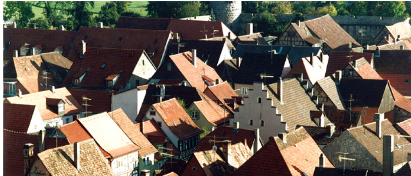
einheitliche, geschlossene Dachflächen
