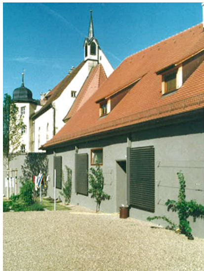
Wand-Solaranlage im Innenhof
