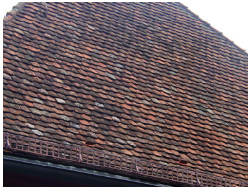
geschlossene Dachflächen, neu und alt
