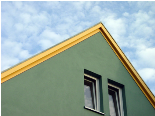
Ortgangausbildung mit schmalem Stirnbrett aus Holz
