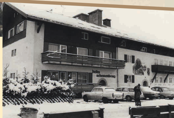
Der fertige Anbau nach Norden im Winter
