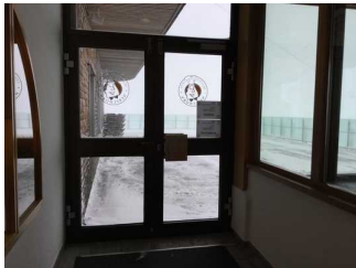
Station Höfatsblick: Tür II zwischen Marktrestaurant und Terrasse
