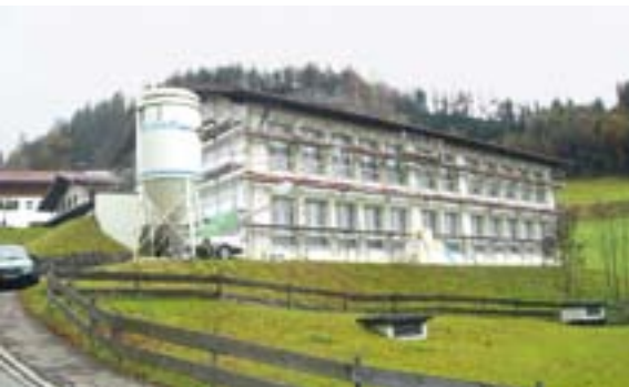
Sanierungsarbeiten am Kindergarten St. Barbara in Tiefenbach
