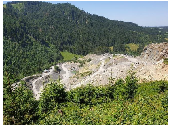
Abbildung 13: Blick von Nordosten auf den Steinbruch
