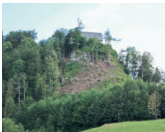
Sanierter Weg zur Schöllanger Burkbirke
