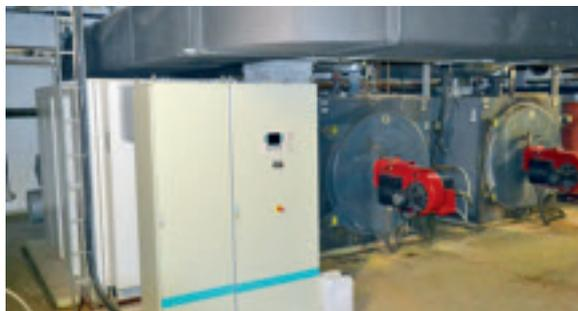
Heizungsanlage mit BHKW und beiden Ölbrennern
