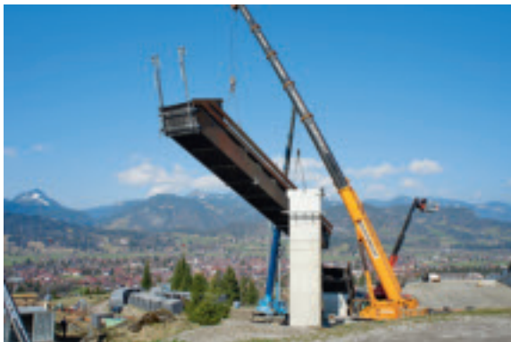
Abbruch der alten Schanze
