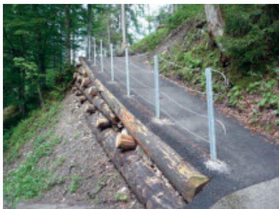
Erneuerung von Holzverbau und Geländer
