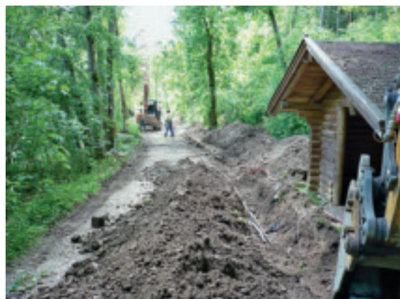
Kanalbauarbeiten am Faltenbachspielplatz
