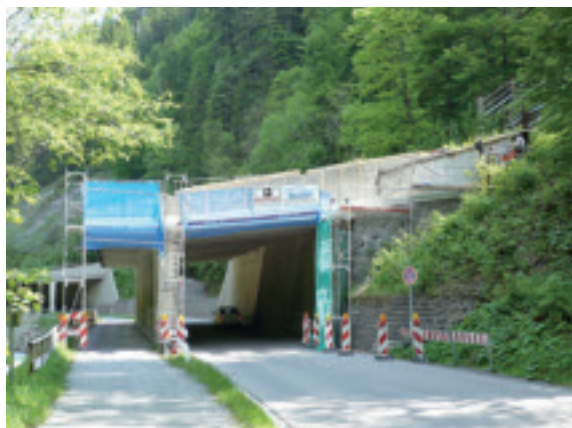
Sanierungsarbeiten an der Lawinengalerie
