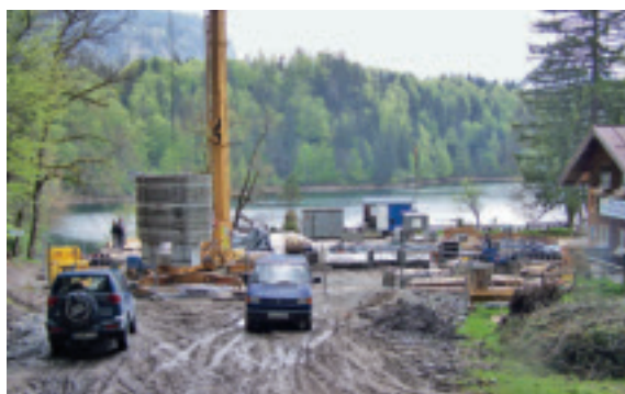
Bauarbeiten am neuen Pavillon
