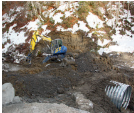
Umweltschonender Einbau des Durchlassrohres mit einem Schreitbagger
