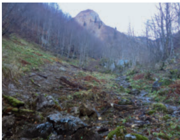
Rechts ist der Wanderweg und links die Kanaltrasse zu sehen.
