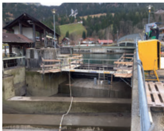
Hochwasserschutz Trettach, Bauabschnitt Mühlenwehr
