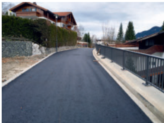
Abschluss der Bauarbeiten in Jauchen
