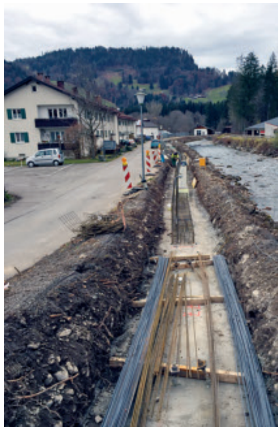
Hochwasserschutz Trettach, Bauabschnitt Rubinger Straße
