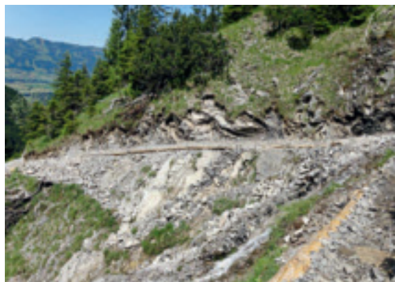
Der sanierte Weg zum Gaisalpsee
