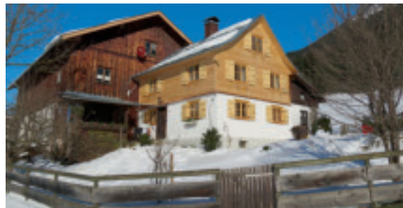
Saniertes Anwesen Kalkofenweg 25
