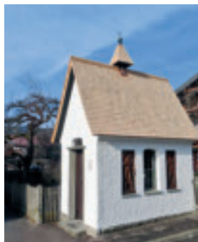
Im neuen Glanz: die renovierte Pestkapelle
