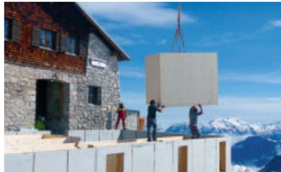
Die fertig montierten „Kojen“ werden per Hubschrauber direkt eingesetzt.
