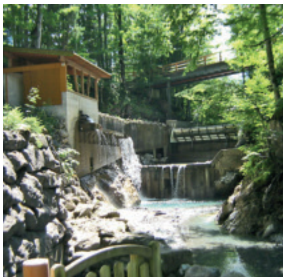
Wasserkraftanlage mit bis zu 200 kW an der Trettach in Dietersberg – Zwingbrücke, vom Golfplatzparkplatz 500 m Richtung Gerstruben, Ansprechpartner ist Karl Müller
