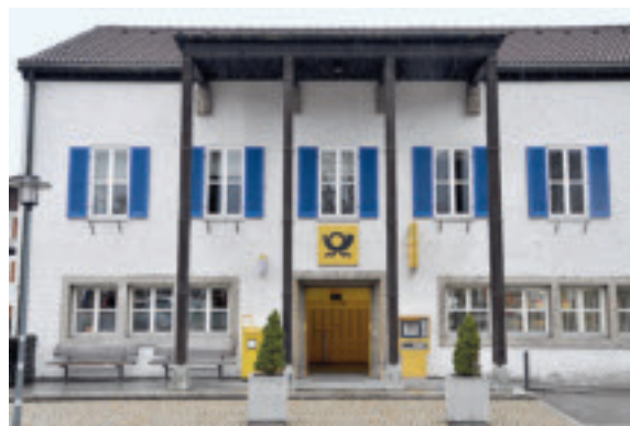
Postfiliale am Bahnhofplatz
