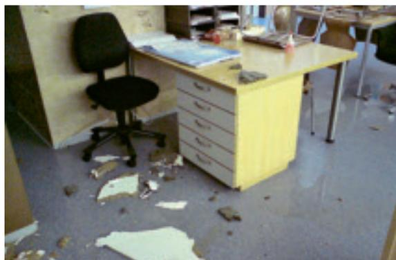
Wasserschaden durch undichtes Dach.
