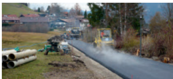
Die Asphalttragschicht wird in der Verbindungsstraße aufgebracht
