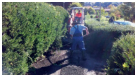
Sanierungsarbeiten am Mühlenweg
