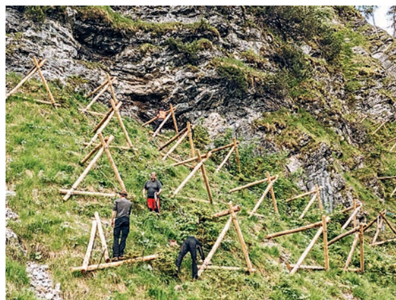
Die neuen Gleitschneeböcke sichern die jungen Bäume in der Anwuchsphase, bis diese ausreichend groß und stabil sind, um ihre Schutzwirkung selbst zu entfalten.
