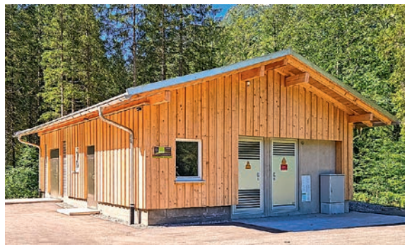
Mit dem neuen Brunnenhaus investiert die Wasserversorgung Oberstdorf gezielt in die Versorgungssicherheit.
