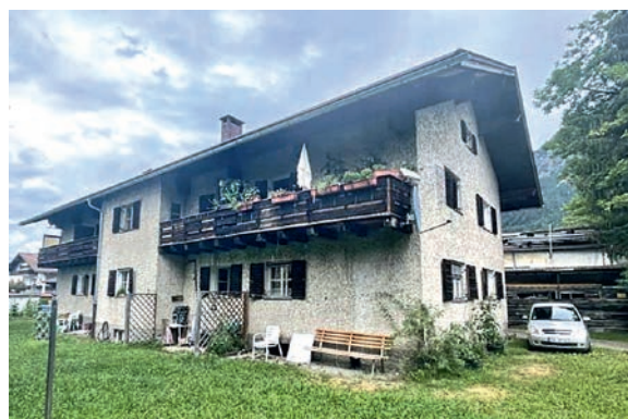
Das Gebäude vor der Sanierung
