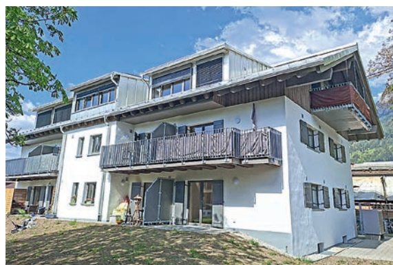
Das Gebäude nach der Sanierung
