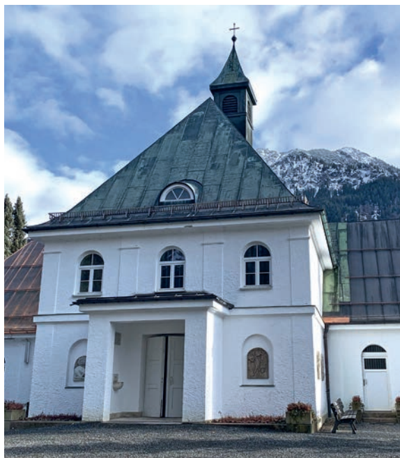
Die neue Aussegnungshalle
