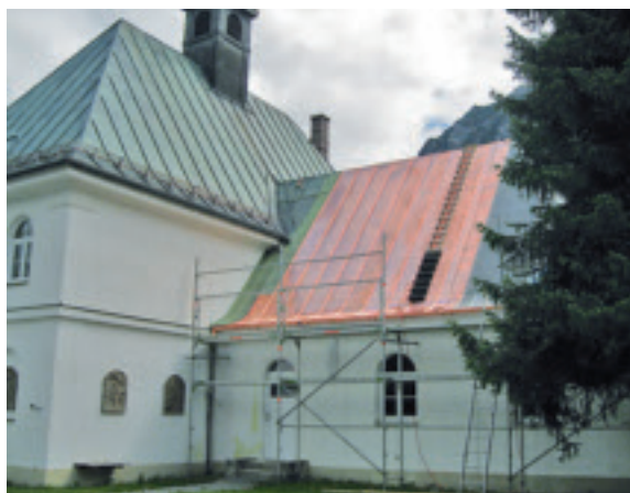
Der Südteil des Leichenhauses am Waldfriedhof wird mit einem neuen Kupferdach ausgestattet
