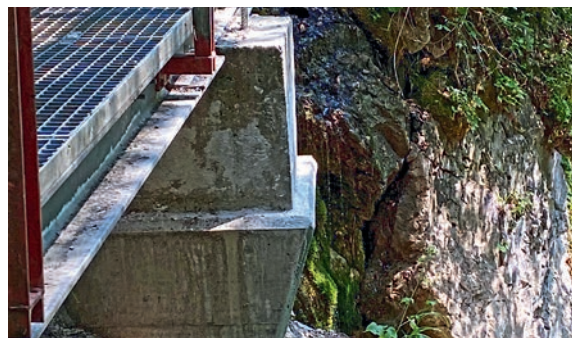
... und so nach der Sanierung.
