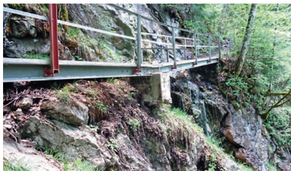
So sah das Fundament im Faltenbachtobel vorher aus ...
