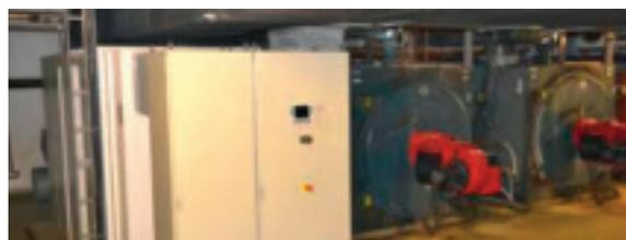
Heizungsanlage der Oberstdorf Therme mit Blockheizkraftwerk (links im Bild) und den beiden Ölbrennern (rechts im Bild)
