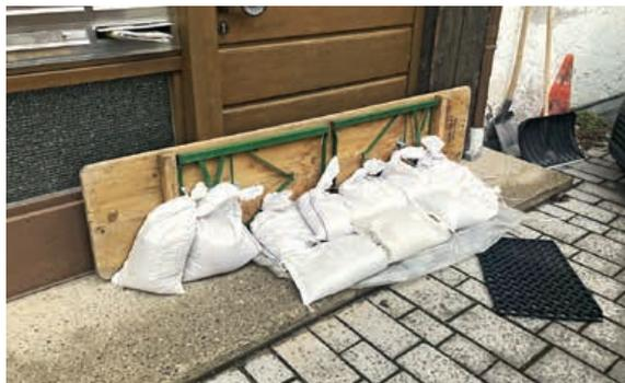
Sandsäcke werden verwendet um schnell eine wirkungsvolle Barriere zu schaffen. Zum Schutz von Haus- und Keller- eingängen sind aufgestapelte Sandsäcke ebenfalls sehr hilfreich, da sie sich leicht verlegen lassen und nicht zu schwer sind.
