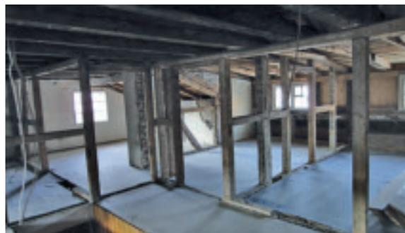
Teil des Dachgeschosses nach dem Herausbrechen der Wände
