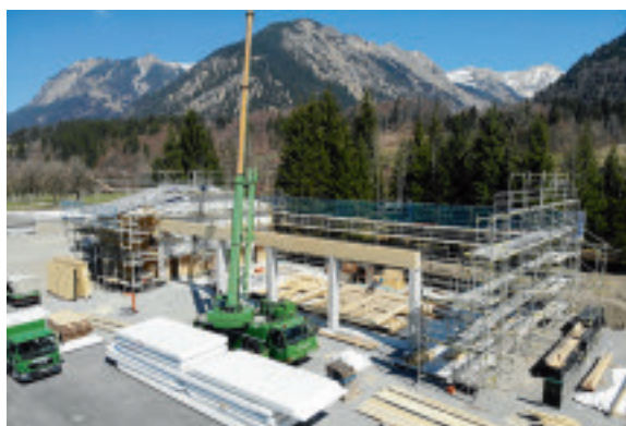
Die Maschinenhalle wird aufgerichtet
