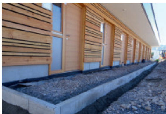
Die Fertigstellung schreitet voran
