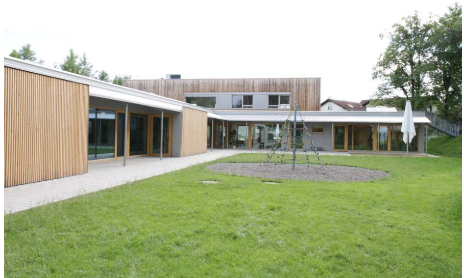
Abbruch und Neubau Kindergarten Felderhalde Realisierung im KfW 70 Standard
