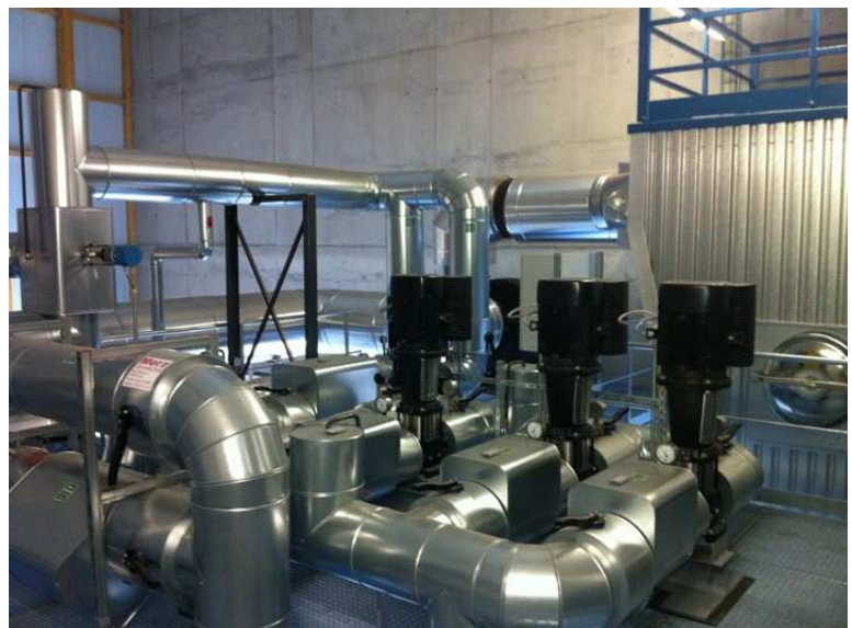
Neubau Betriebsgebäude Hackschnitzelanlage für die Nahwärmeversorgung von privaten und städtischen Gebäuden
