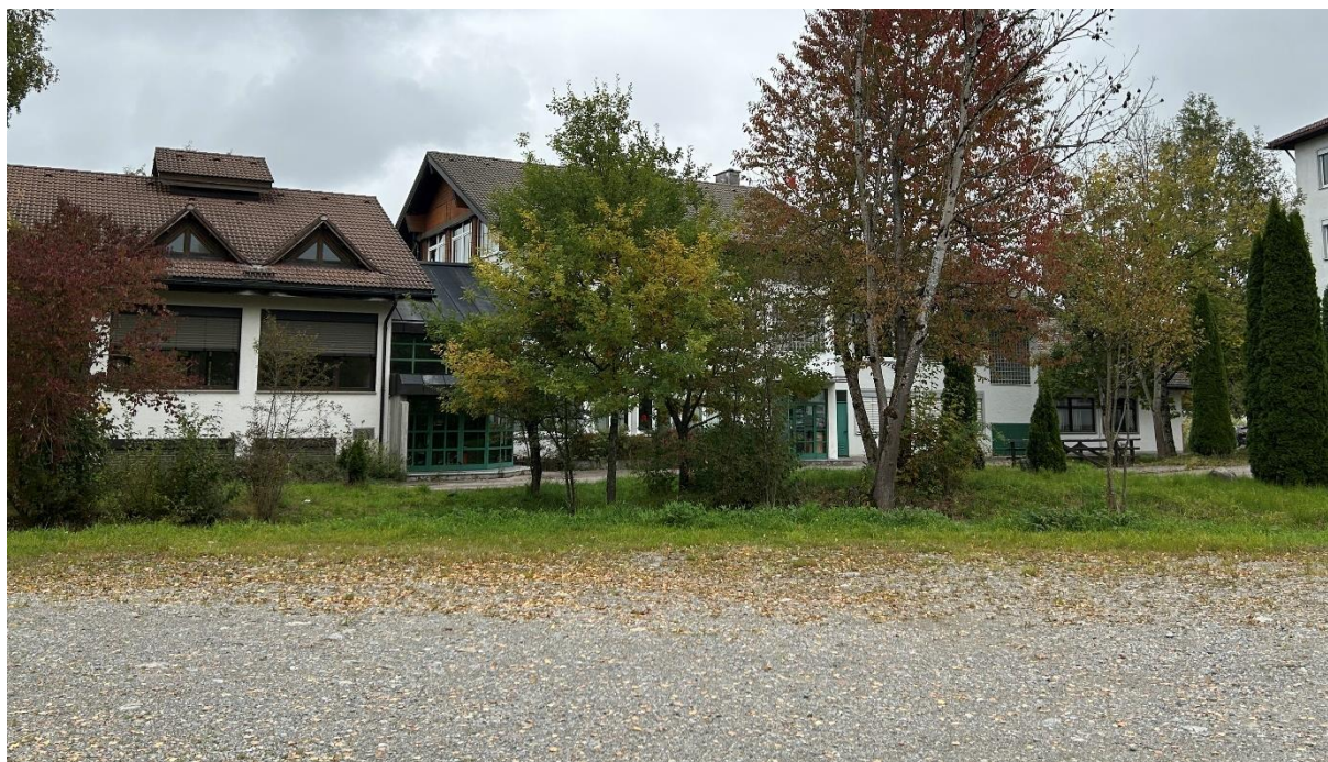
Abbildung 47: Gebäudekomplex Seidenstr. 35/1 (NTA) mit Parkierungsfläche (KE)
