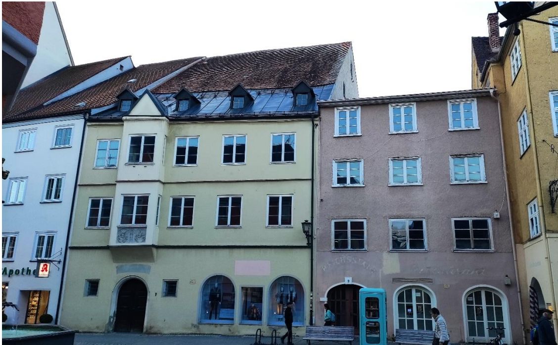
Abbildung 39: Wassertorstr. 7 (Denkmal) 9 und 11 (KE)
