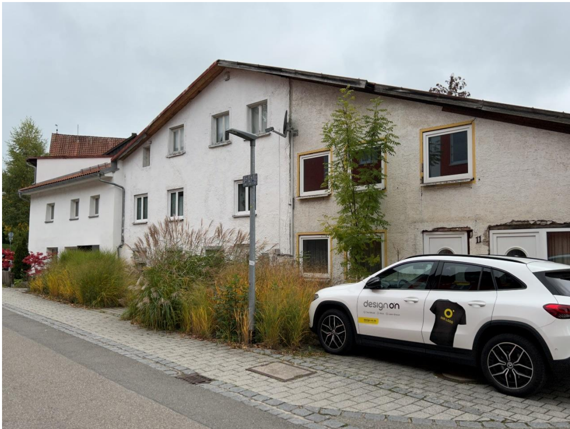
Abbildung 45: Leerstehendes Privatgebäude Seidenstraße 11 (KE)
