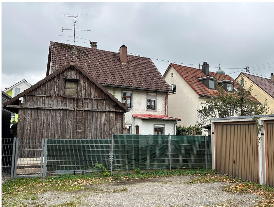
Abbildung 44: Privatgebäude Webergasse von Seite Schwanenweg (KE)
