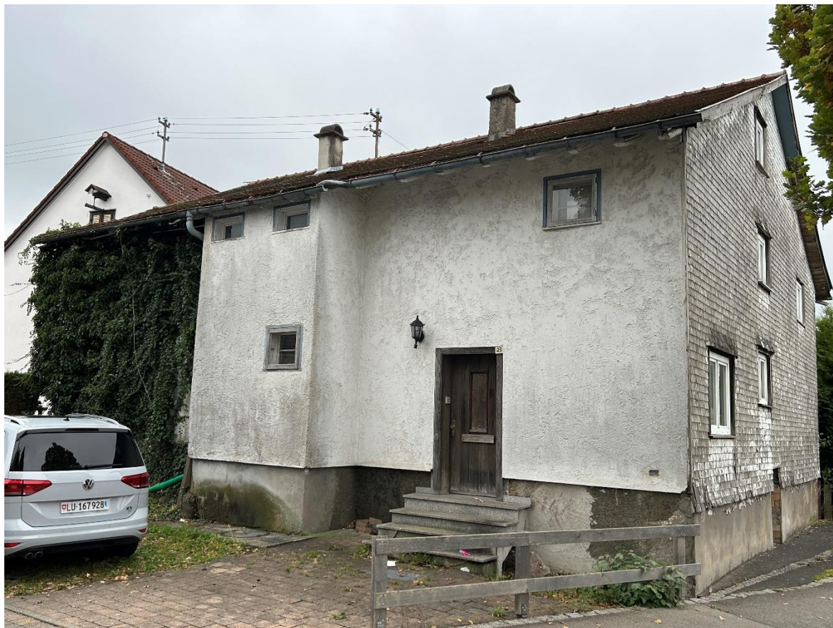
Abbildung 43: Leerstehendes Privatgebäude Schwanenweg 25 (KE)
