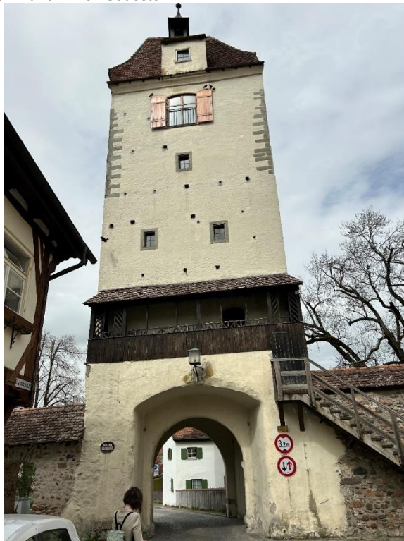
Abbildung 126: Espantor mit Turm von Südosten
