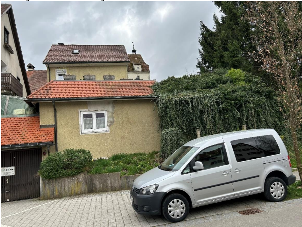
Abbildung 129: Seitenansicht Privatgebäude Rainstraße 6
