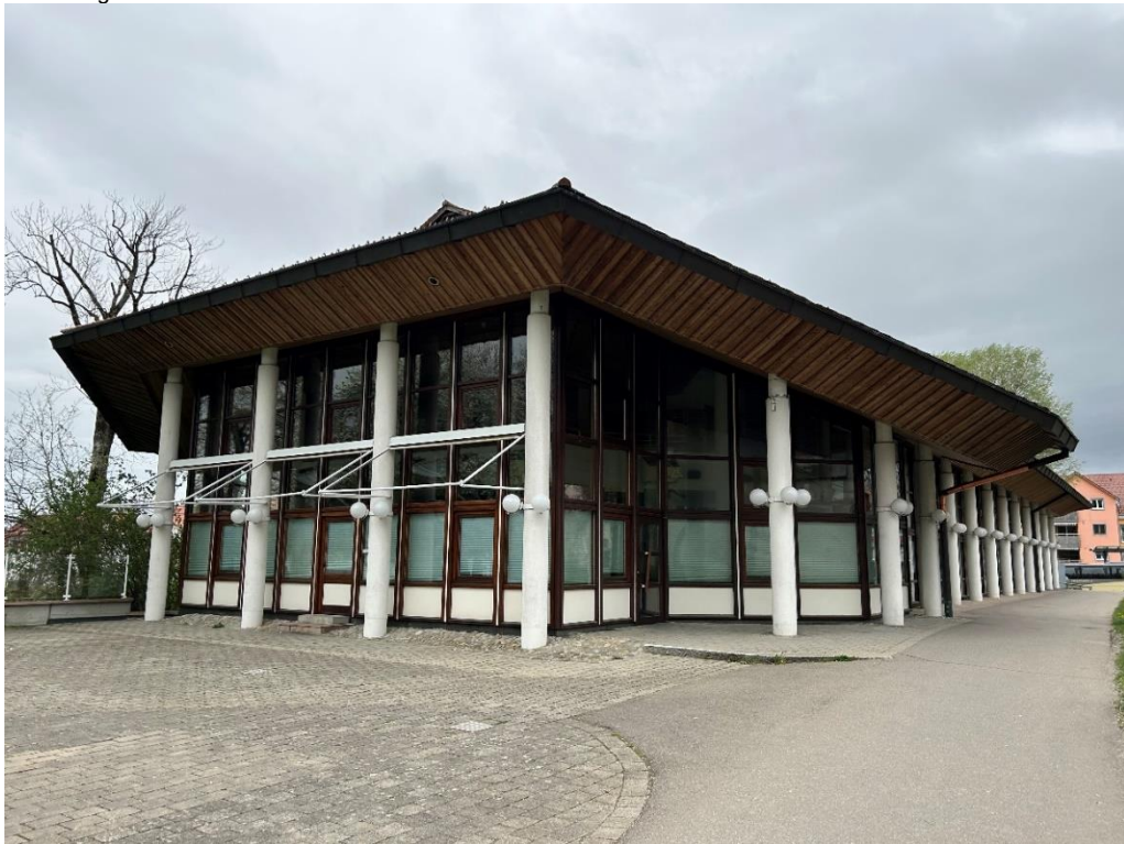
Abbildung 153: Kurhaus am Park von Süden
