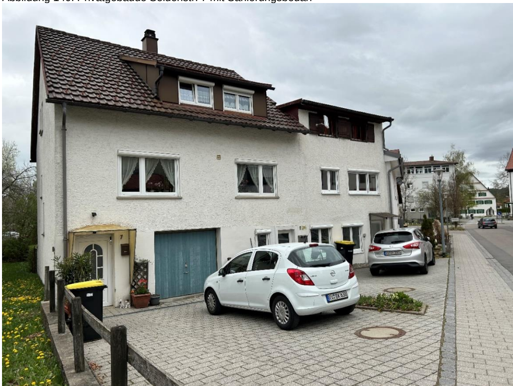
Abbildung 140: Privatgebäude Seidenstr. 7 mit Sanierungsbedarf
