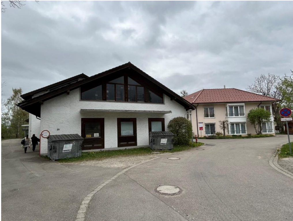
Abbildung 147: Gebäudekomplexe Seidenstr. 35/1 (NTA) u. 39 (Haus d. Pflege St. Leonhard) von Südwesten
