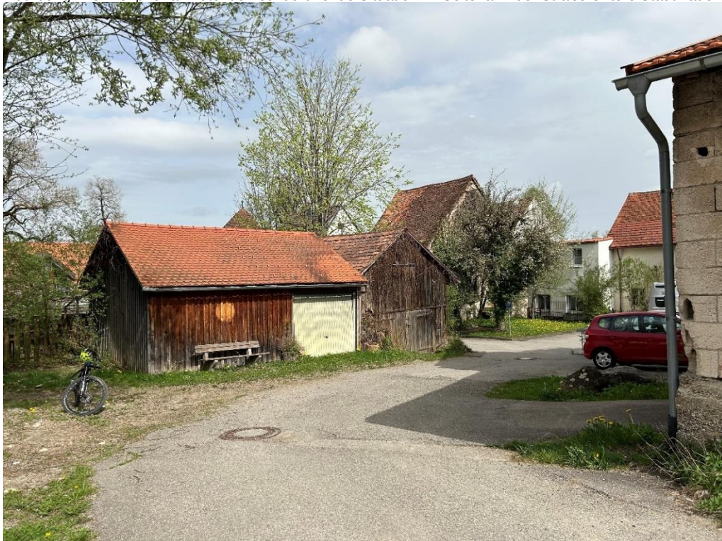
Abbildung 173: Peripher anmutende neuzuordnende Situation im Seitenarm der Straße Untere Stadtmauer
