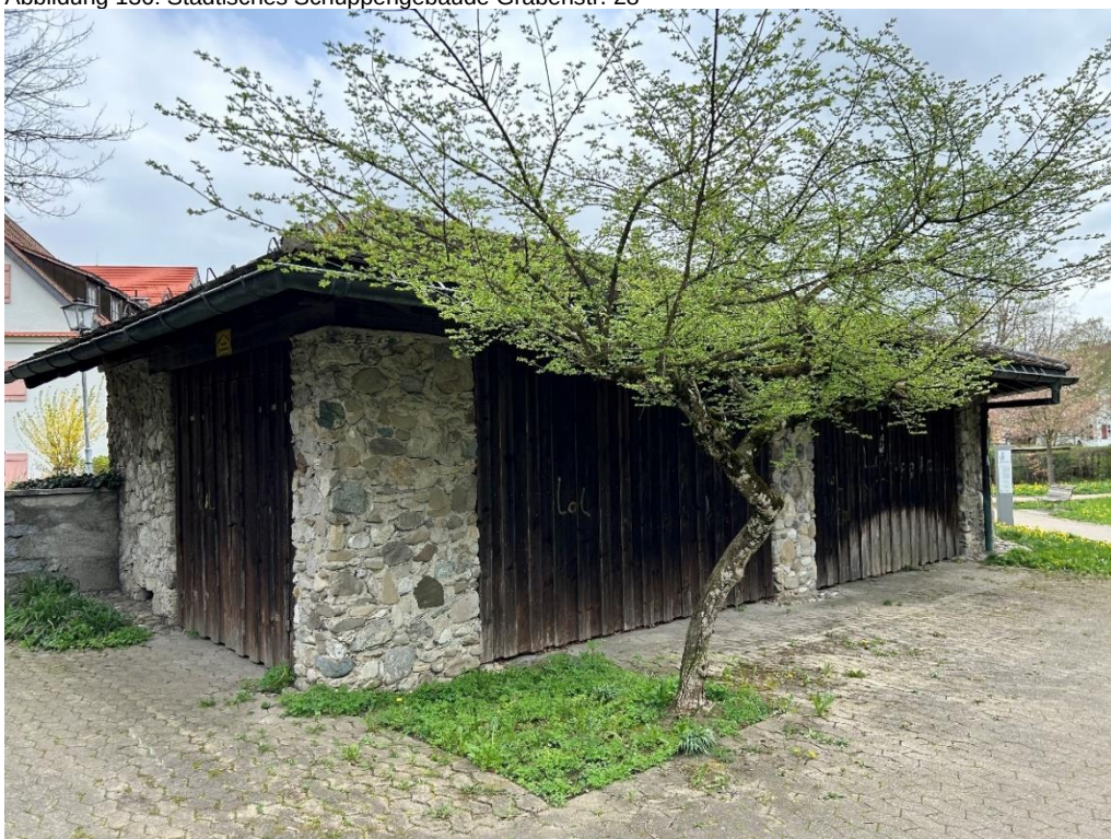
Abbildung 136: Städtisches Schuppengebäude Grabenstr. 28
