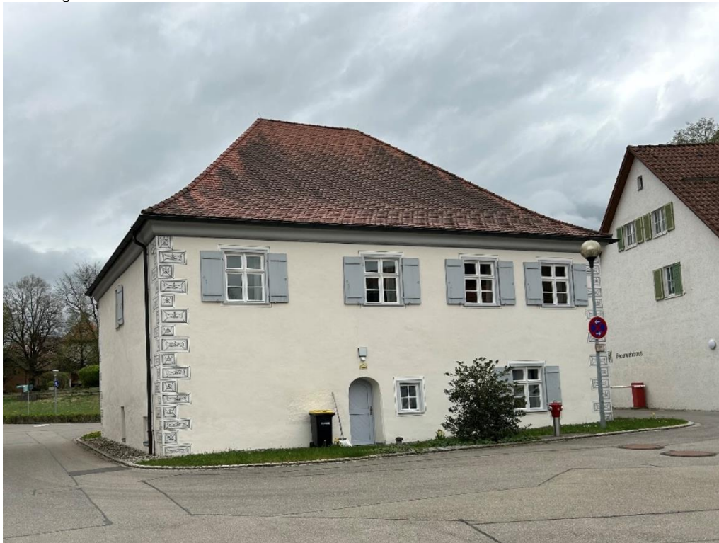
Abbildung 139: Rückansicht Gebäude Rainstr. 12
