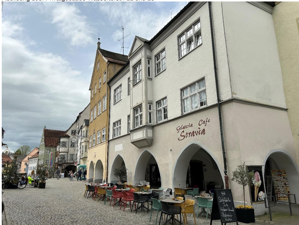
Abbildung 105: Privatgebäude Wassertorstr. 11 und 13
