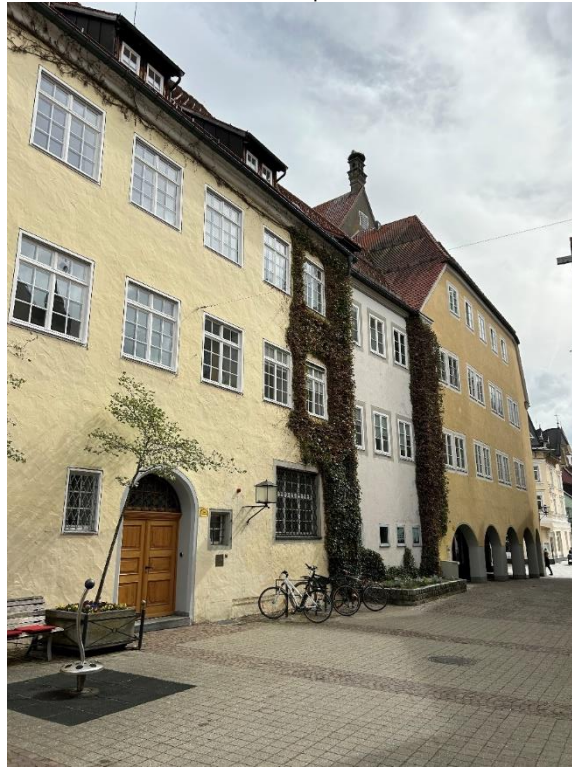
Abbildung 107: Seitenansicht des Rathauses von der Espantorstraße
