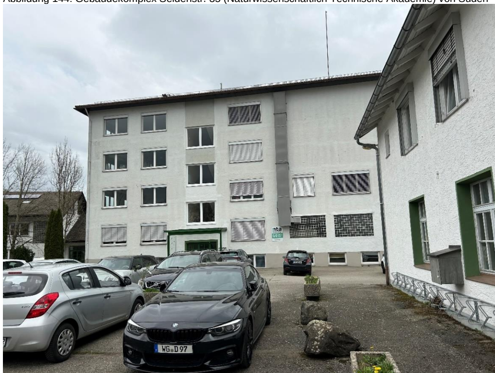
Abbildung 144: Gebäudekomplex Seidenstr. 35 (Naturwissenschaftlich Technische Akademie) von Süden
