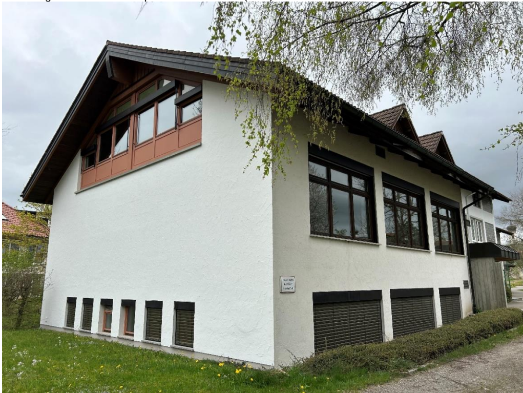
Abbildung 145: Gebäudekomplex Seidenstr. 35/1 (NTA) von Südwesten
