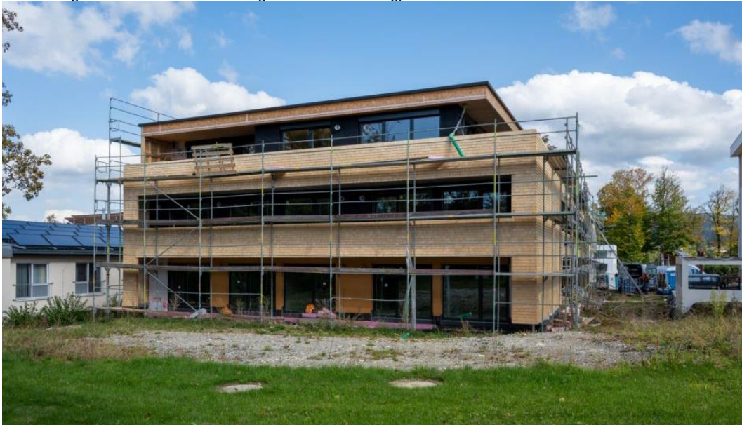
Abbildung 59: Werdender Erweiterungsbau im Herrenbergpark
