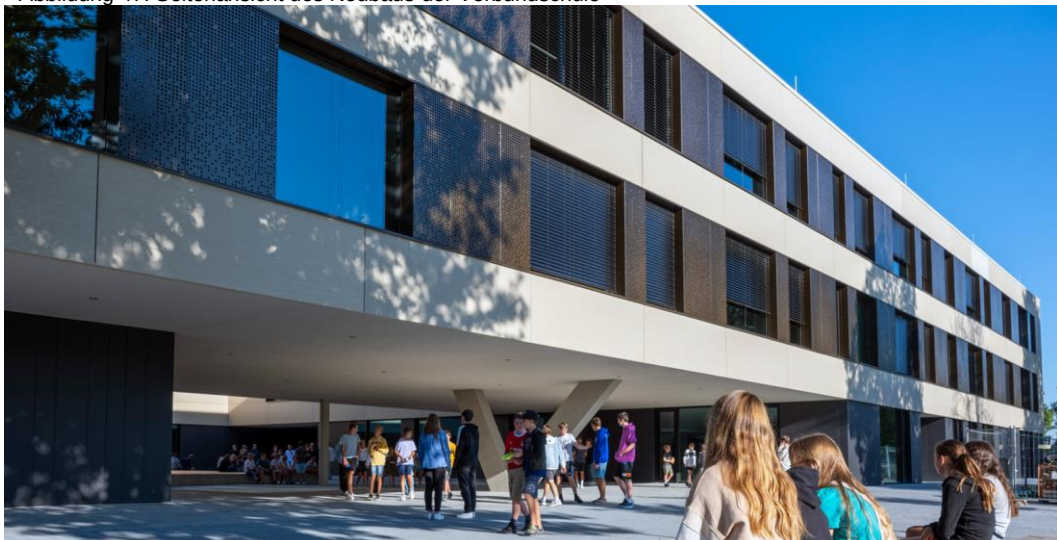
Abbildung 47: Seitenansicht des Neubaus der Verbundschule
