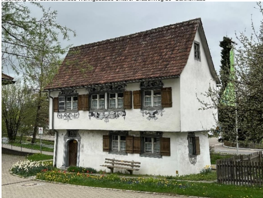
Abbildung 156: Leerstehendes Wohngebäude Unterer Grabenweg 16 "Gärtnerhaus"
