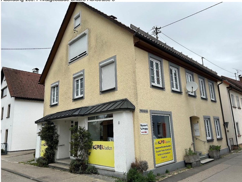
Abbildung 160: Privatgebäude Untere Achstraße 8
