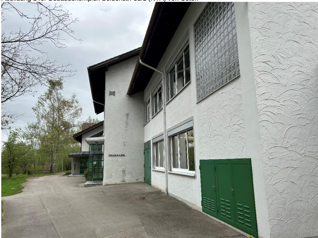
Abbildung 146: Gebäudekomplex Seidenstr. 35/1 (NTA) von Osten
