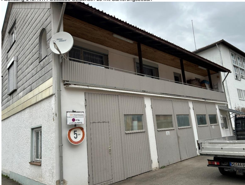
Abbildung 143: NTA-Gebäude Seidenstr. 15 mit Sanierungsbedarf
