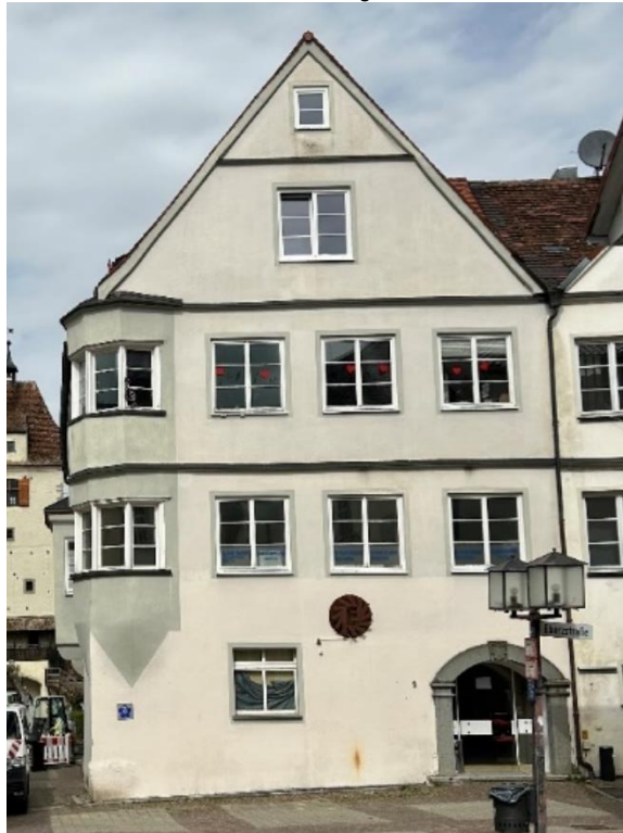
Abbildung 113: Privatgebäude Eberzstraße 1 mit Sanierungsbedarf
