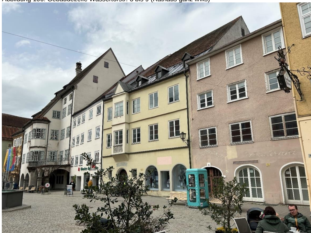
Abbildung 106: Gebäudezeile Wassertorstr. 3 bis 9 (Rathaus ganz links)
