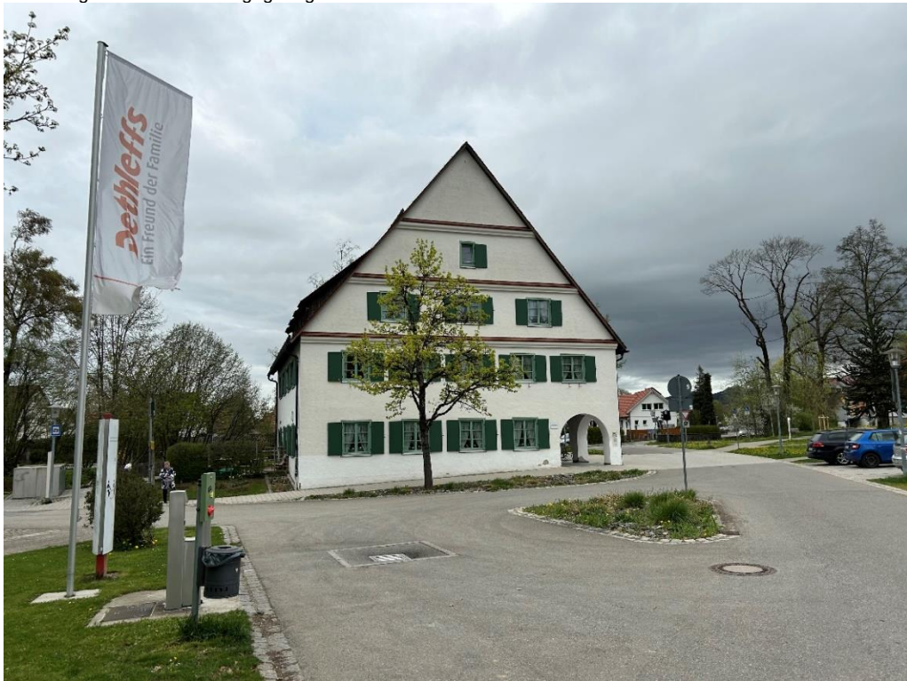
Abbildung 216: Haus der Begegnung "Untere Mühle"
