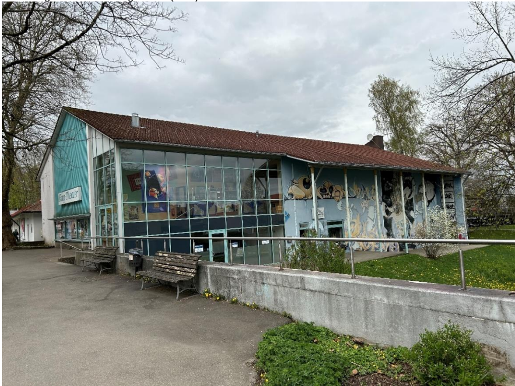
Abbildung 133. Neues Ringtheater (Kino) von Osten
