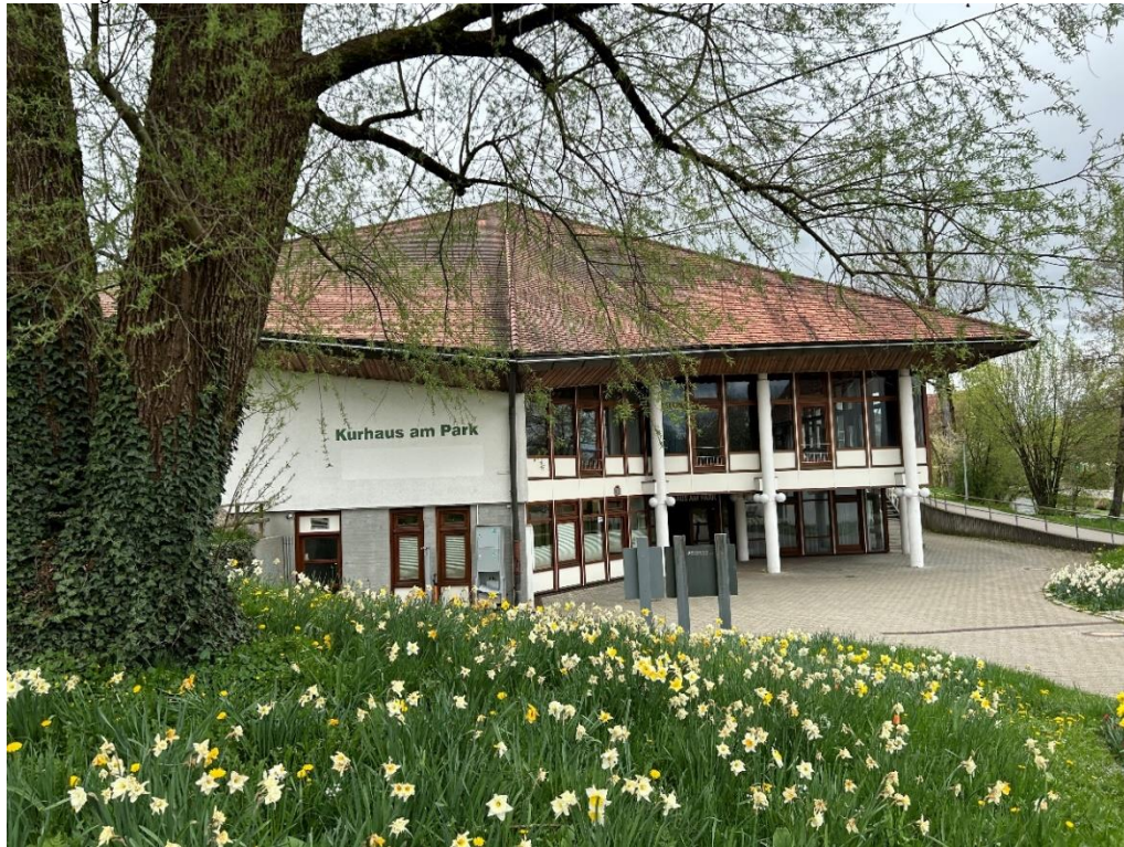
Abbildung 155: Kurhaus am Park von Osten
