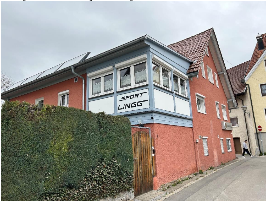
Abbildung 163: Seitenansicht Privatgebäude Gerbergasse 7
