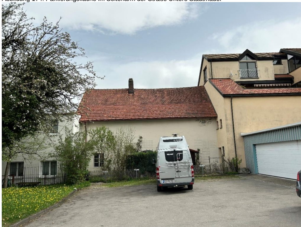
Abbildung 174: Parkierungsfläche im Seitenarm der Straße Untere Stadtmauer
