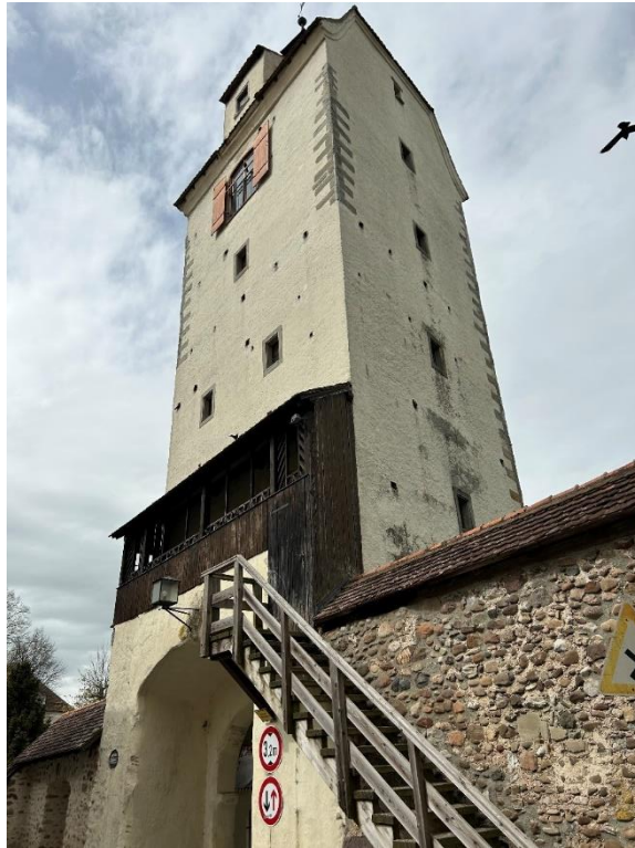
Abbildung 125: Espantor mit Turm von Nordosten
