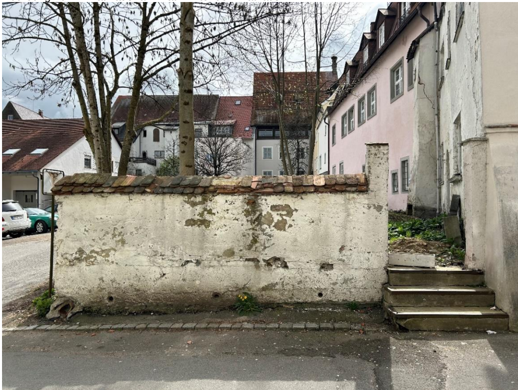
Abbildung 167: Privatmauer am Platz hinter dem Rathaus
