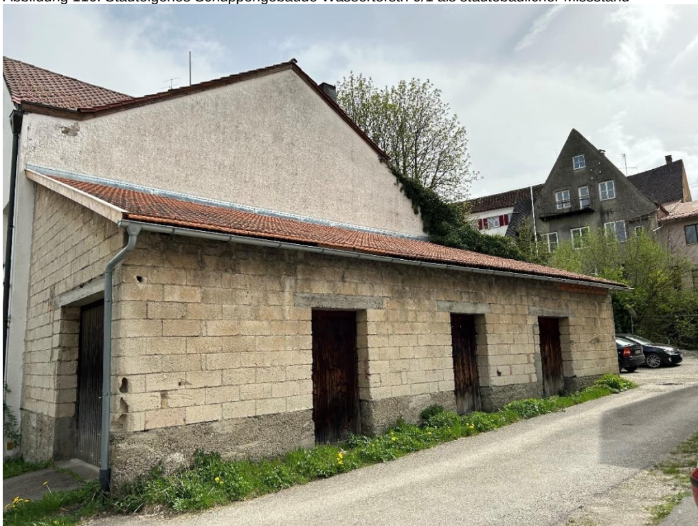
Abbildung 116: Stadteigenes Schuppengebäude Wassertorstr. 9/1 als städtebaulicher Missstand
