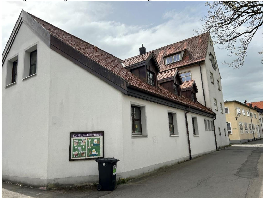
Abbildung 121: Rückwärtige Ansicht der Gebäude des Evangelischen Nikolaikinderhauses
