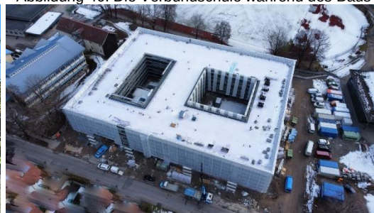
Abbildung 46: Die Verbundschule während des Baus
