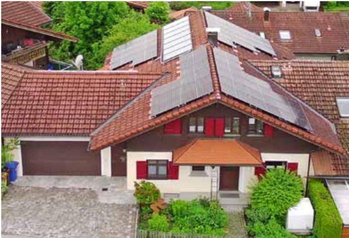
*PV-Anlage auf dem Ost-West-Dach von Manfred Wolf – auch stärker untergliederte Dächer eignen sich zur Sonnenenergie-Nutzung! Hinten links ist die Solarthermie-Anlage installiert und vor dem Haus rechts die Luft-Wärmepumpe.
