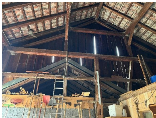
Abbildung 5: Südwand mit offenem Giebel/Übergang in die Garage
