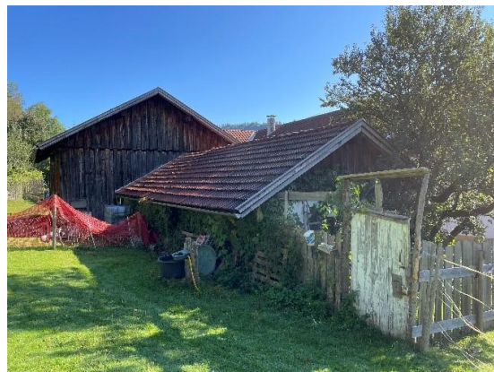
Abbildung 4: Bestandsgebäude von der Rückseite (Westen)
