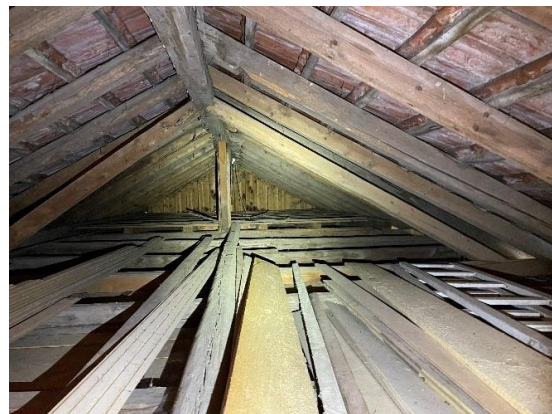
Abbildung 6: Dachstuhl über der Garage
