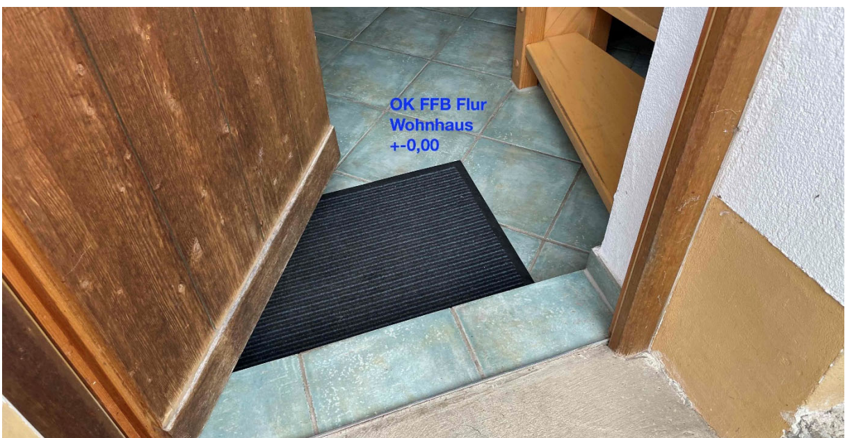
Abbildung 4: Eingangsbereich Wohnhaus als Bezugshöhe
