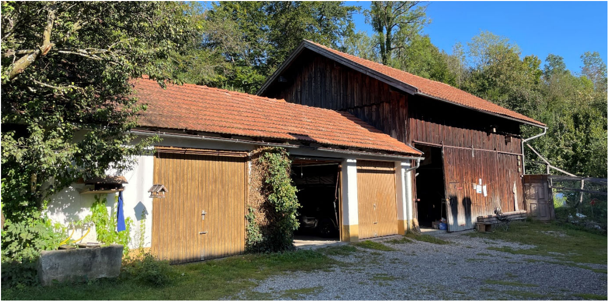
Abbildung 2: Garagengebäude und Stadel Greggenhofen 1
