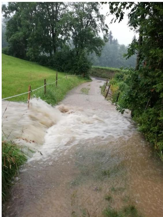
Abbildung 7: Abfluss über den Feldweg zum Bachlauf (Einlauf links vom Weg überlastet)
